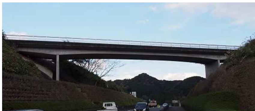
図 10 道路を跨ぐ橋梁の例（高千穂町管理 第2号跨道橋）
