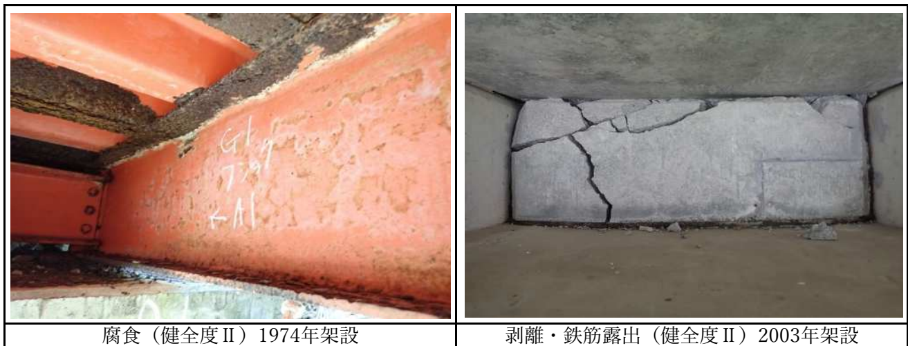
図 6 損傷状況
