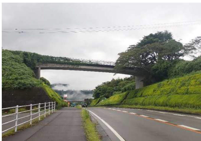
図 10 道路を跨ぐ橋梁の例（高千穂管理 第2号跨道橋）
