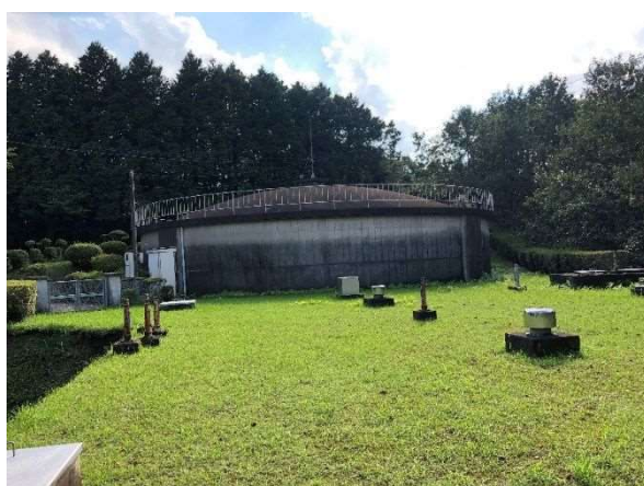
金比羅配水池
