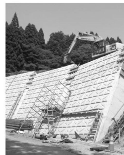
工事ははじまったばかり
