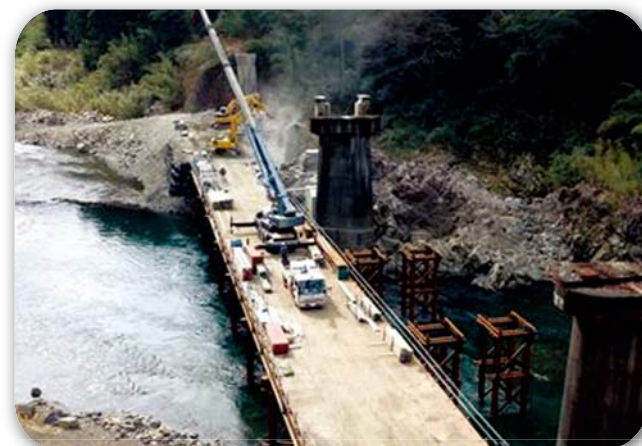
上部橋の解体風景
