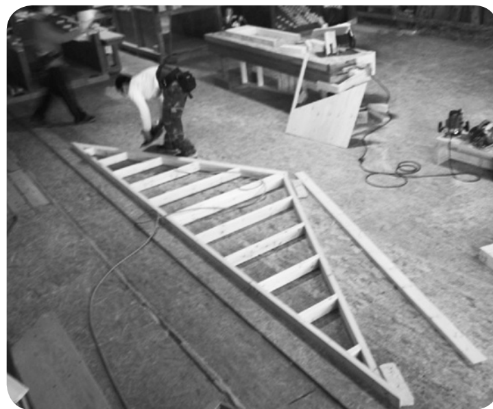
2×4のパネル組立て(ユニックス工場)
