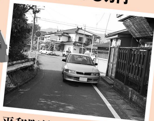
平和町線 道路改良工事
