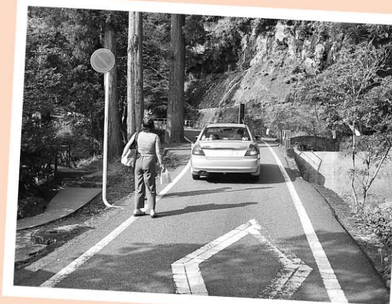
高千穂峡線 道路改良工事
