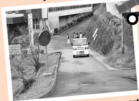
上町～栗原線 道路改良工事
