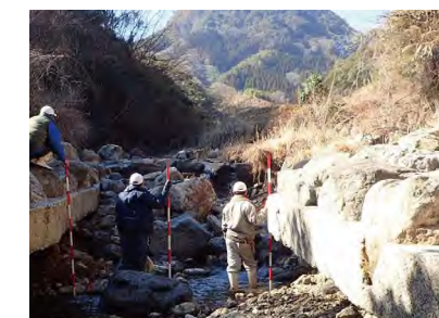
洗掘された河床を復旧し護岸を守ります
