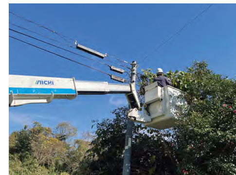
光ケーブル支障木伐採作業の様子
