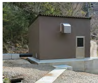
小水力発電建屋
