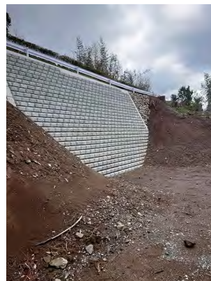
令和4年台風災害箇所 の復旧後（岩戸地区）
