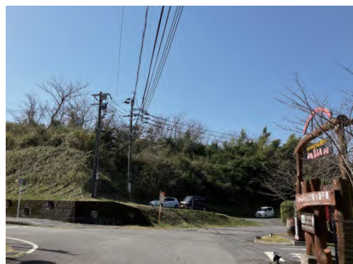
吾平宅地造成箇所
