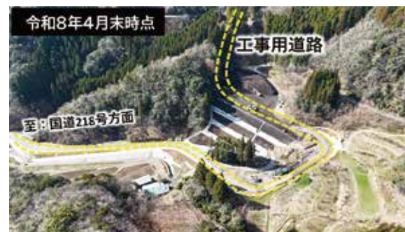
はしかみだに 薑谷地区工事用道路工事（押方・芝原）
