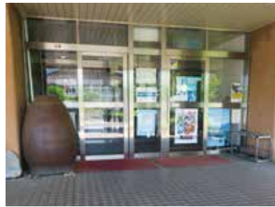
コミュニティセンターの入口ドア
