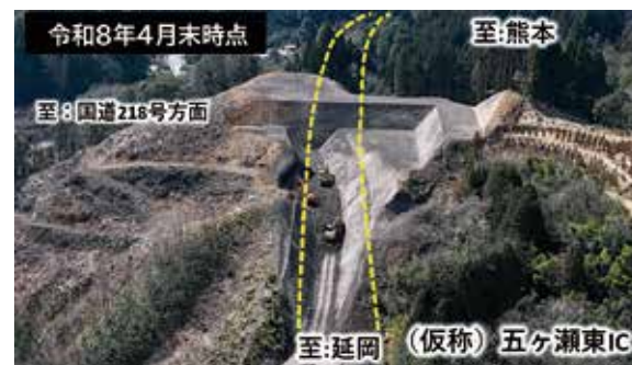
三ヶ所地区改良工事（五ヶ瀬）
