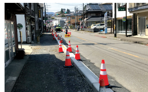
道路工事が進む三田井地区
