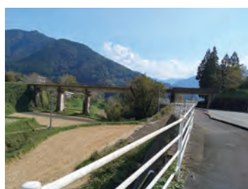
県道をまたぐ桁又橋梁
