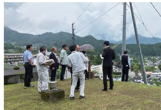
建設から 71 年経過した城山配水池
