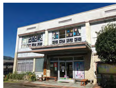
老朽化している 子育て支援センター
