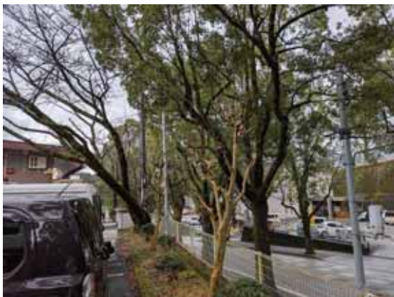
支障木に覆われた役場前の光回線
