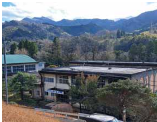
建設後 47 年以上が経過した高千穂中学校
