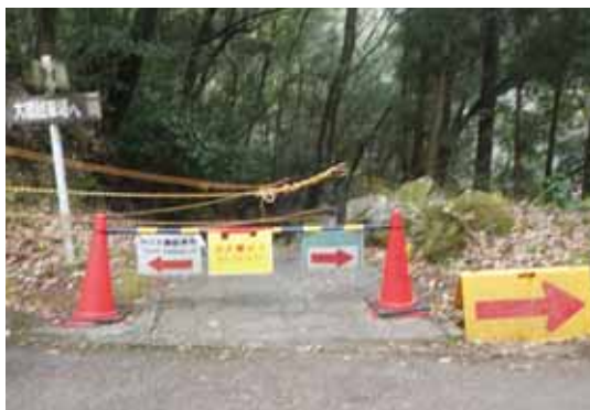
通行止めの状況
