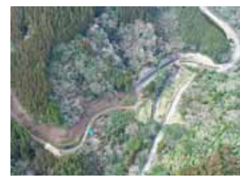
押方地区林道工事
