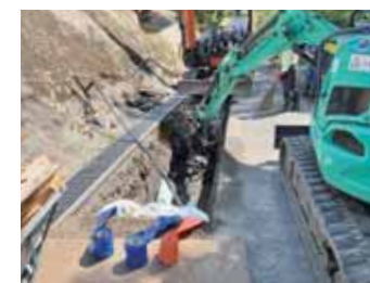
管路更新工事
