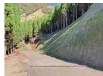
林道整備（法面工事）
