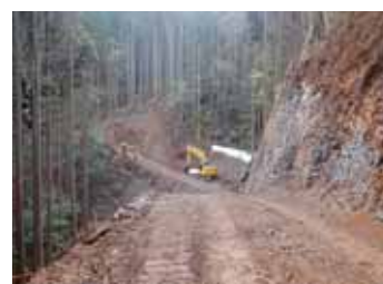
林道新規開設工事
