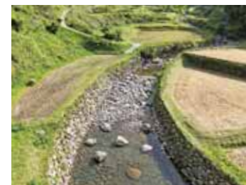
河川災害復旧工事
