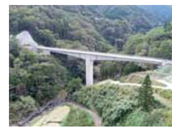
向山地区林道工事
