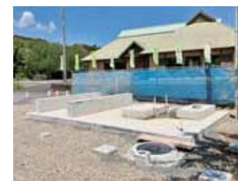
ポンプ室整備
