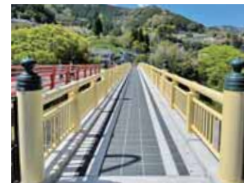
天岩戸橋側道橋
