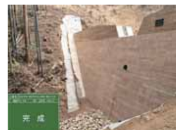
治山ダム設置工事
