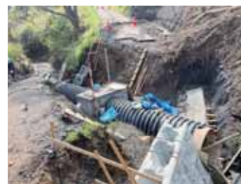
集落道の改良工事
