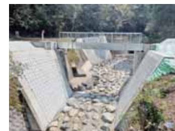
水路橋の災害復旧
