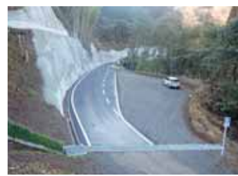
押方地区林道工事
