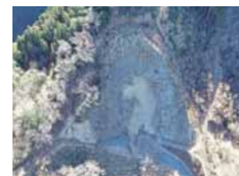
地すべり防止工事（着手前）
