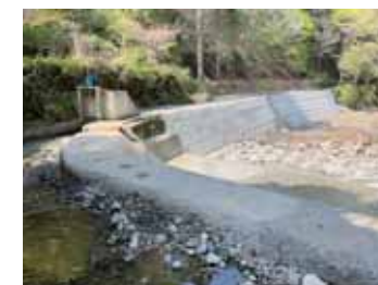
頭首工の災害復旧
