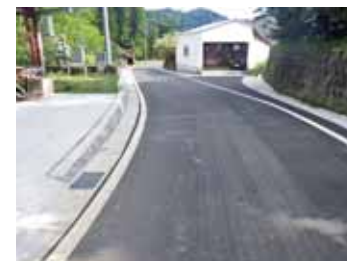
道路改良工事
