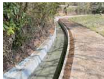
用水路の改修
