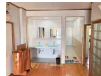
交流施設の改修
