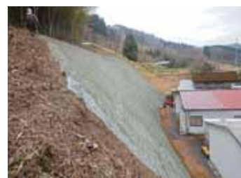
山林法面保護工事
