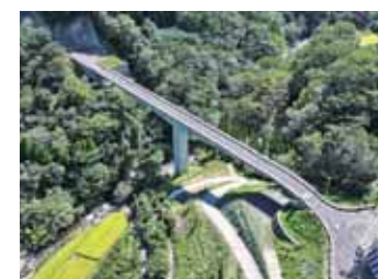
林道橋建設工事
