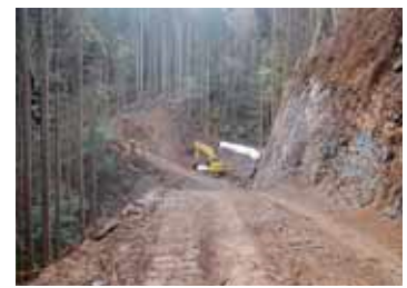
林道新規開設工事
