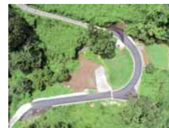
集落道の改良工事
