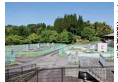
下水道処理施設
