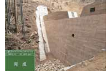
治山ダム設置工事
