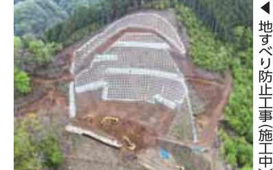
地すべり防止工事(施工中)
