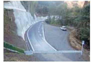
押方地区林道工事
