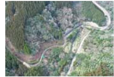
押方地区林道工事
