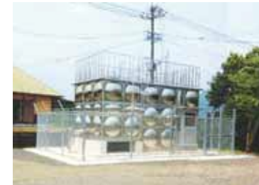
ポンプ室整備
