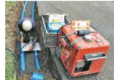
管路更新工事
