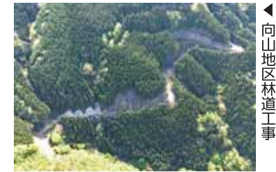
向山地区林道工事
