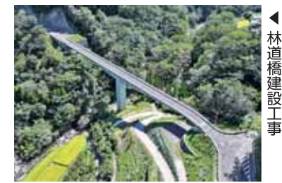
林道橋建設工事
