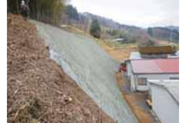
山林法面保護工事
