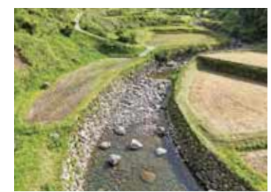
◀ 河川災害復旧工事
