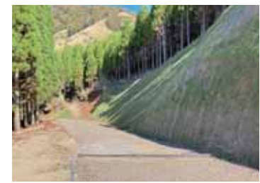
林道整備(法面工事)
