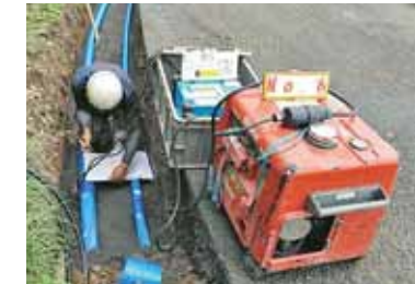
管路更新工事
