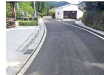
◀ 道路改良工事
