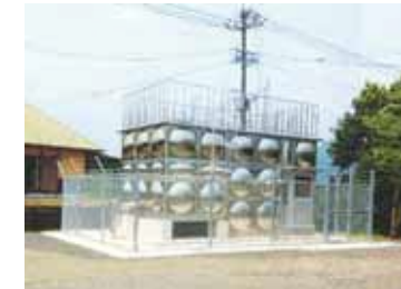
ポンプ室整備
