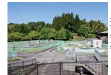
下水道処理施設
