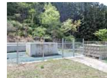
簡易水道施設
