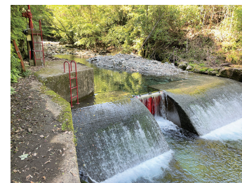
取水・転倒ゲート（改修）
