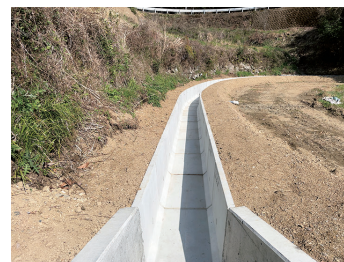
用水路改修（I型水路）
