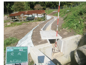
農業用排水路
