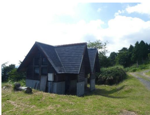
フリーテントサイト トイレ
