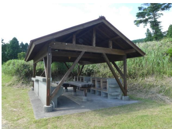
炊事棟 中央に作業台
