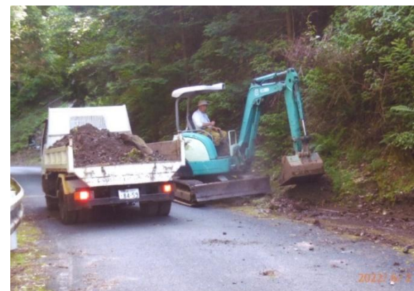
林道土砂除去
