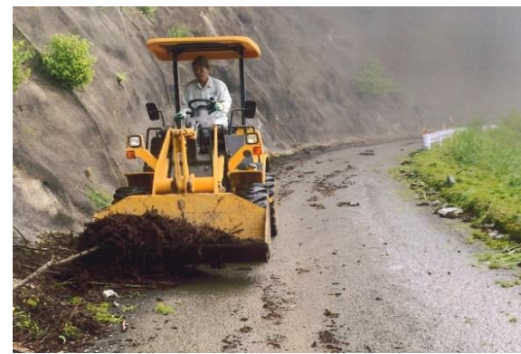
土砂等除去作業
