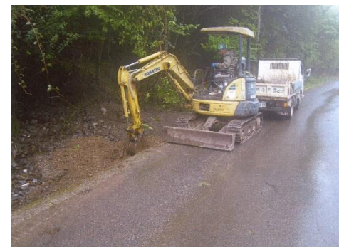
側溝清掃作業
