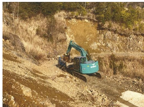
路面清掃作業
