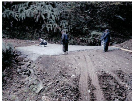
補修状況（洗越）
