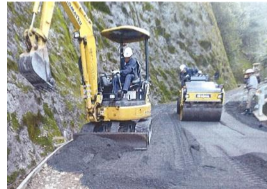
施工状況（路面補修）
