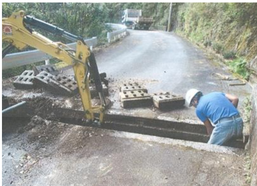
施工状況（横断側溝清掃）
