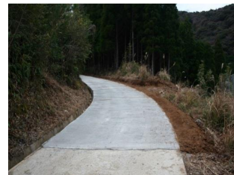
施工状況（コンクリート舗装）
