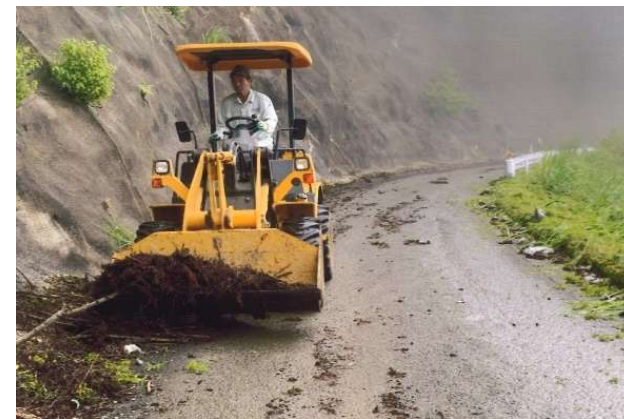
土砂等除去作業
