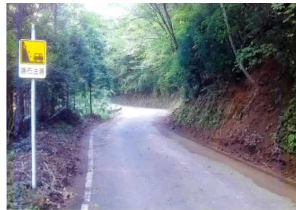
林道土砂除去
